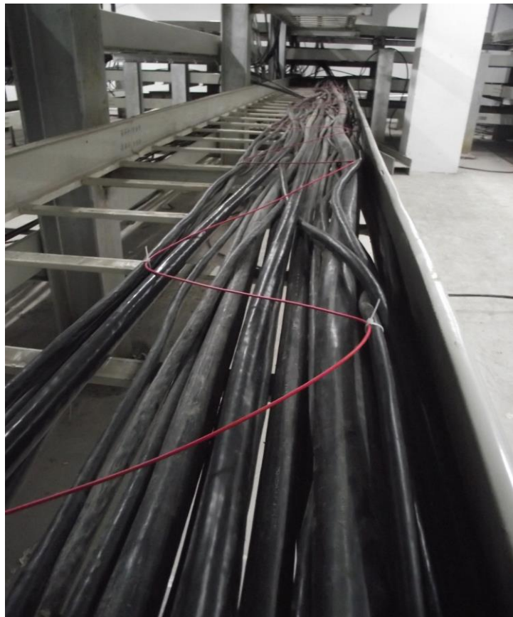
感温探测光缆敷设示意图（低压动力/控制电缆）
