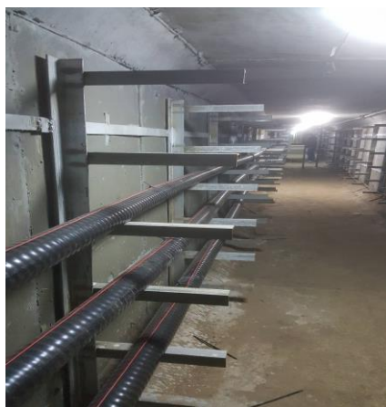
电缆隧道中，光缆安装在电缆表面
